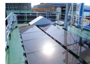
太陽光パネル
